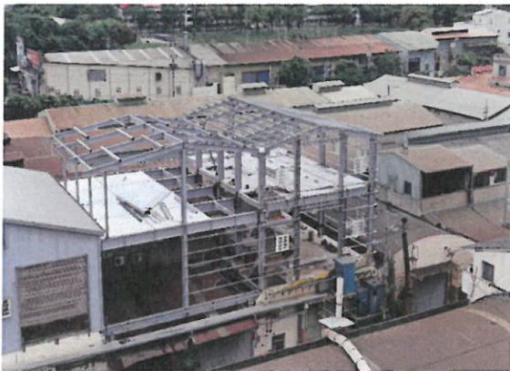
108 巨崑工業有限公司廠房新建工程
