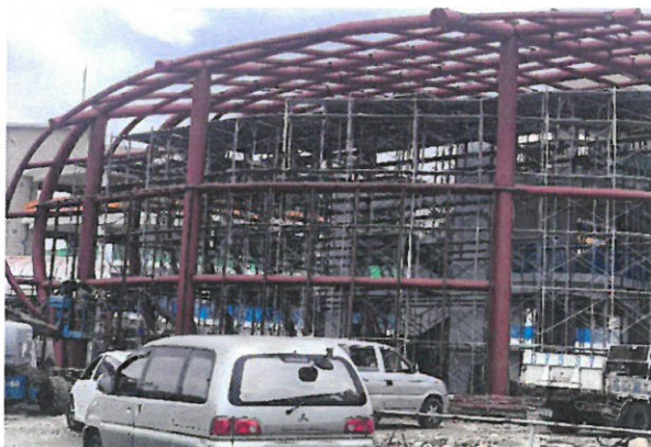
109 廊子國小新建工程
