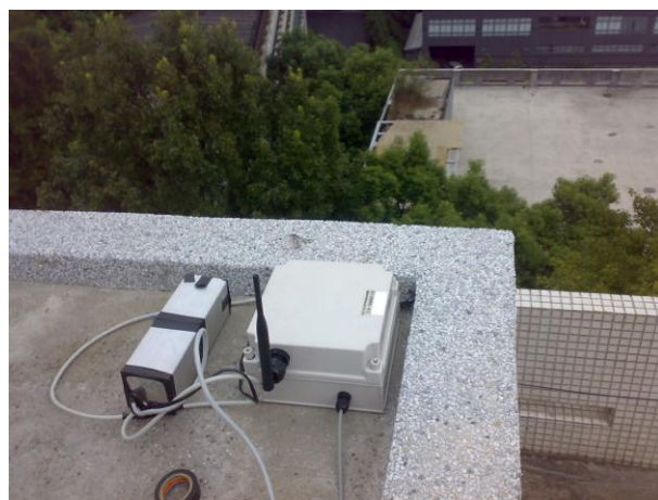
格致樓屋頂 GPS 監測設備安裝
